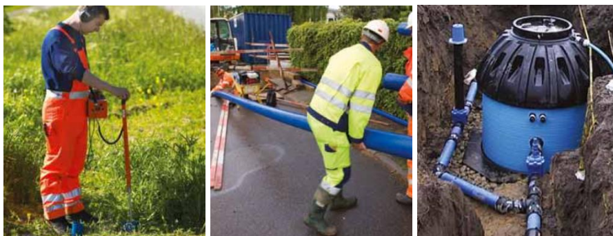
Figura 111. Medidas adotadas pelo município de Aarhus (da esq. para a dta.: Deteção ultrassónica de vazamentos; Instalação de novos dutos; Instalação de sistema de distribuição. Fonte: https://agma.org.il/wp-content/uploads/2022/11/Aarhus-Water_compressed.pdf .
