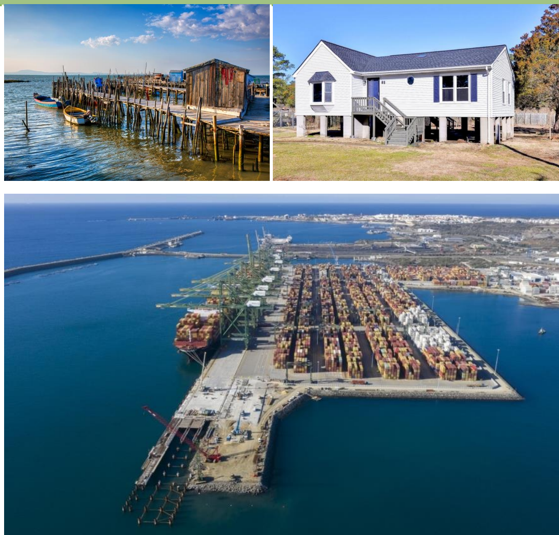
Figura 123. Soluções naturais de acomodação de infraestruturas (cais palafítico da Carrasqueira – topo, esquerda). Desenvolvimento de plano de elevação de infraestruturas em Poquoson, Estados Unidos (topo, direita). Plano do Porto de Sines, exemplificando um dos locais onde a medida é recomendada (base).
