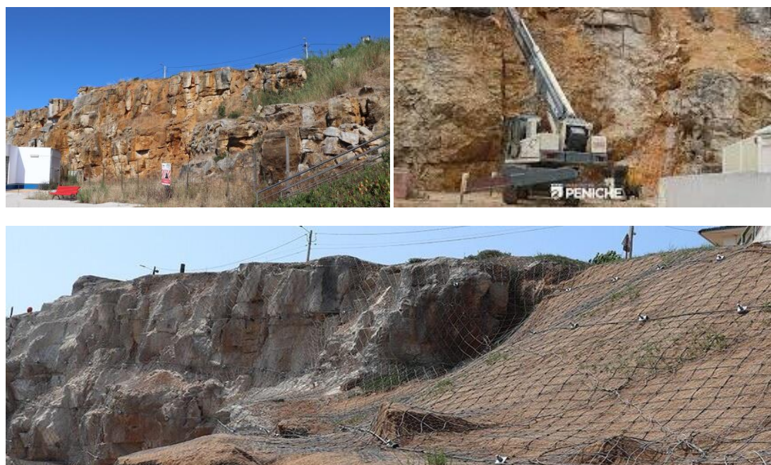
Figura 122. Estabilização da arriba do Porto da Areia Sul. Fonte: Município de Peniche.
