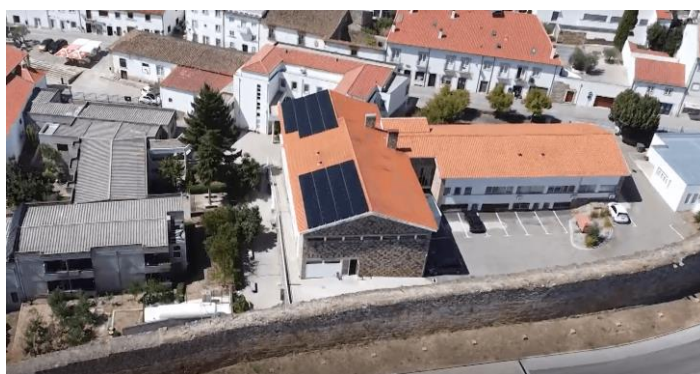
Figura 117. Santa Casa da Misericórdia de Miranda do Douro. Fonte: Cleanwatts.
