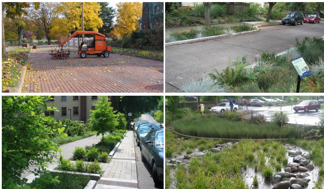
Figura 136. Exemplos de técnicas de Low Impact Development implementadas em Portland: a) Construção de pavimentos permeáveis (EcoLock Pavers) na 21st e 22nd Avenue; b) Implementação de trincheiras de infiltração e "rain gardens" na Siskiyou Green Street; c) Implementação de trincheiras de infiltração e "rain gardens" na 12th Avenue; d) Glencoe Elementary School Rain Garden.
